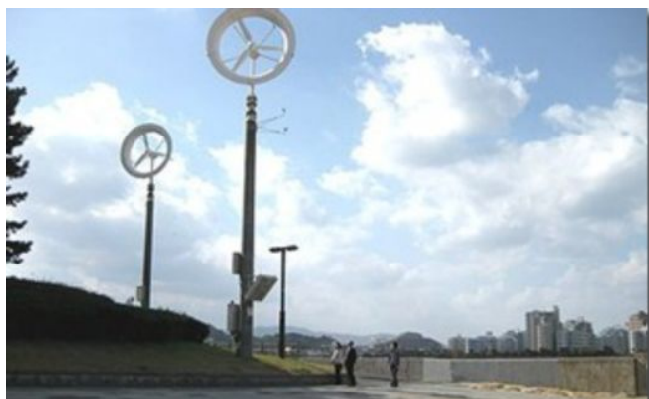
「風レンズ風車」一基当り600~700万円、発電能力3kw。騒音や低周波、バードストライク(鳥が激突する)等の問題がないといわれていますが、汎用化にはコストダウン等の課題が。=11月12日、福岡市シーサイドももち海浜公園
