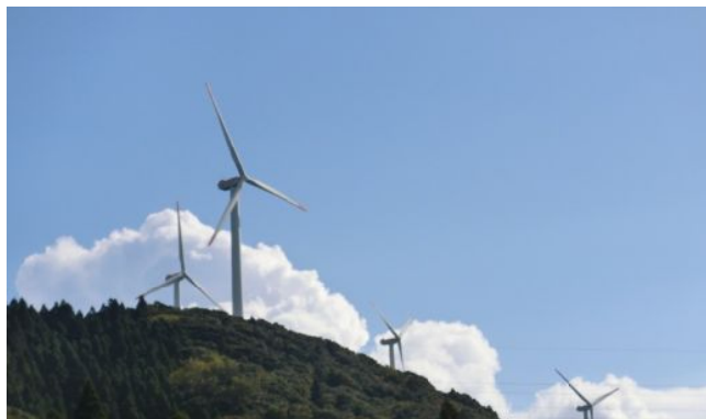
風車には、60mの柱に一辺が30mの羽が3つ。風力3mから発電し、風速25mで自動停止。風力にかかわらず回転速度は一定。=11月13日、鹿児島市牟礼ヶ岡ウィンドファーム
